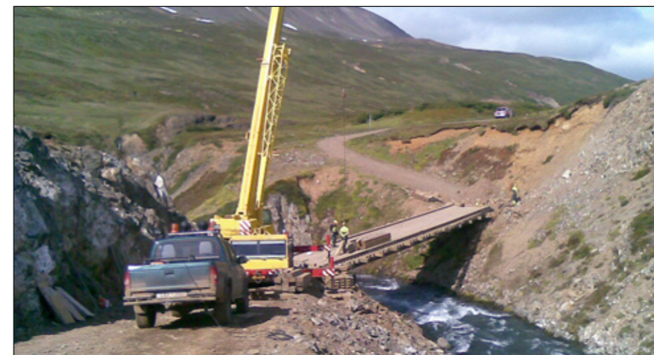
Ný brú á Illagil smíðuð 2009. Tækjasturinn er heldur skárrí en þegar grindarbitabrúin var sett þarna niður árið 1965. Á þessari mynd má sjá að það hefur verið heilmikil ýtuvinna að tengja brúna við veg á sínum tíma.
