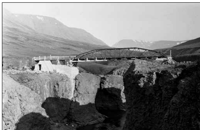
Brúin á Fnjóská hjá Laufási (Dalsmynni) nýbyggð 1930. Grindarbitinn er lítillaga frábrugðin teikningunni frá 1927. Eystri brúar-stöplur er ekki kominn í fulla hæð. Myndasafn Árna Pálssonar.
