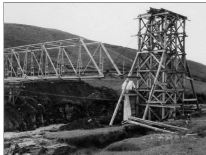
Brúargerð á Jökulsá hjá Brú á Jökudal 1953. Myndin sýnir vel hvernig grindarbiti er dreginn yfir ána á turni. Þetta var venjuleg aðferð við svona brúargerð. Þessi brú er enn í notkun.
