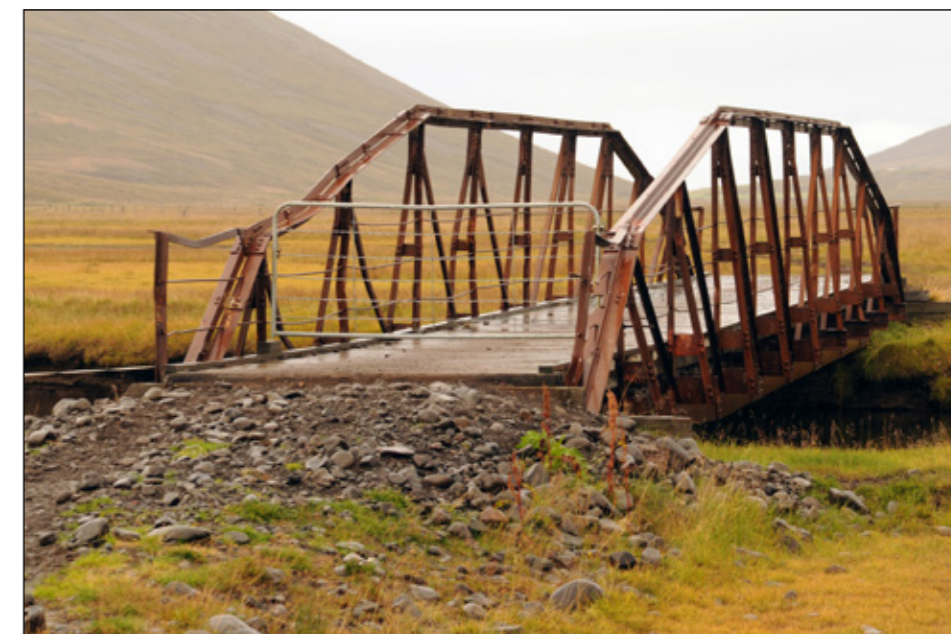
Niræður grindarbitinn frá Fnjóská kominn á elliheimilið yfir Hólsá í Grýtubakkahreppi eftir millilendingu á Illagili. Á þessari mynd má greinilega sjá styrkingarnar frá 1949, tvöföldun efri langbanda og skástífur út frá stöðunum.
