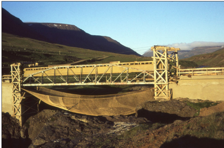
Fnjóská í Dalsmynni hjá Laufási 1963. Búið er að draga I-bitana yfir ána og þeir hanga í gálgum yfir ásetunum. Síðan var gamla grindarbitanum lyft upp og hann dreginn upp á land.
